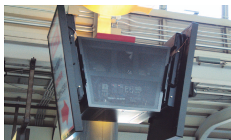
自由通路内22本の柱に縦横両用のGXD-L65H1を設置
