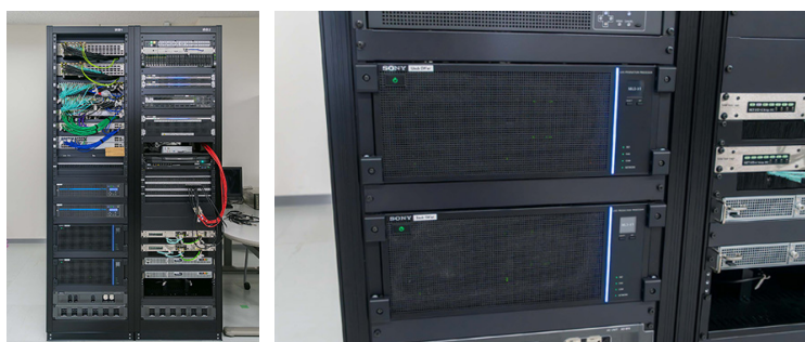
ネットワークスイッチと同じラックに設置した『MLS-X1』のプロセッサ本体
