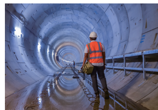
暗所での点検作業
