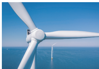
高所での点検作業
