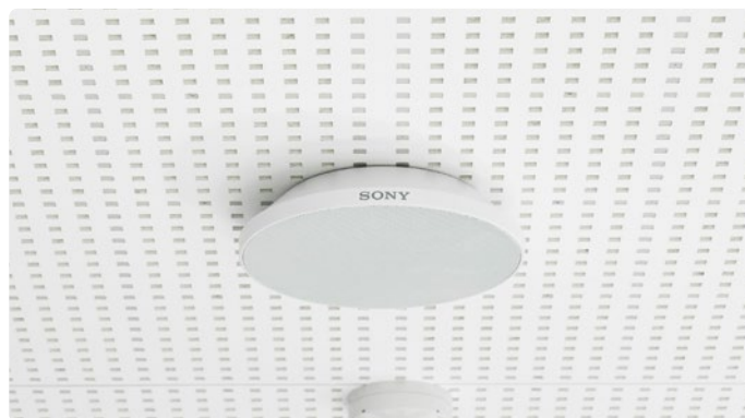
教室中央の天井に設置したビームフォーミングマイクロホン『MAS-A100』
